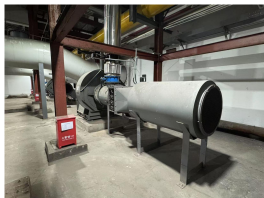
风机基础减振、装消声器
