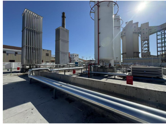
LNG 储罐区围堰（防护堤）
