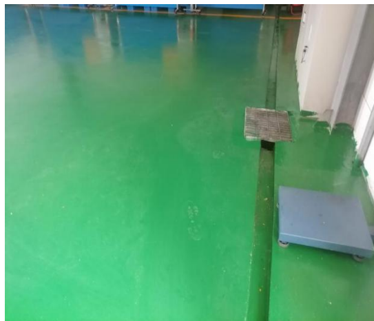
危废暂存间地面防渗
