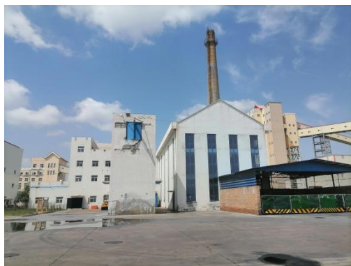
工业场地锅炉房
