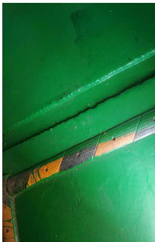
危废库导流槽
